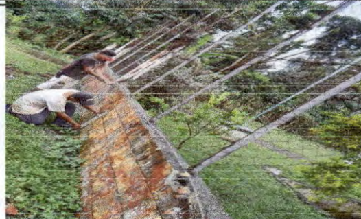
FOTO 8: Reparación de tubo hg y malla galvanizada PATIO I
