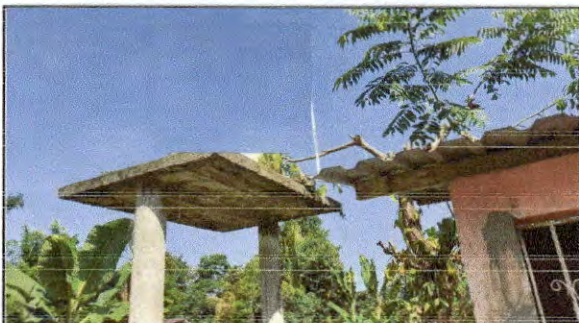
FOTO 3: Sustitución de depósito de agua 1100 lt
